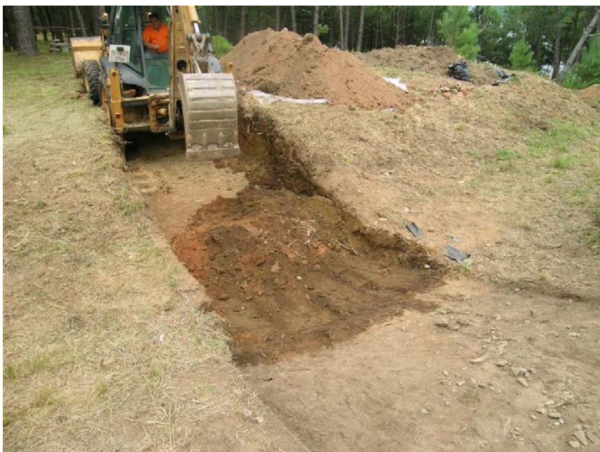
Fig. 6. Retirada con medios mecánicos dos escombros recentes localizados na zona dianteria do foxo
